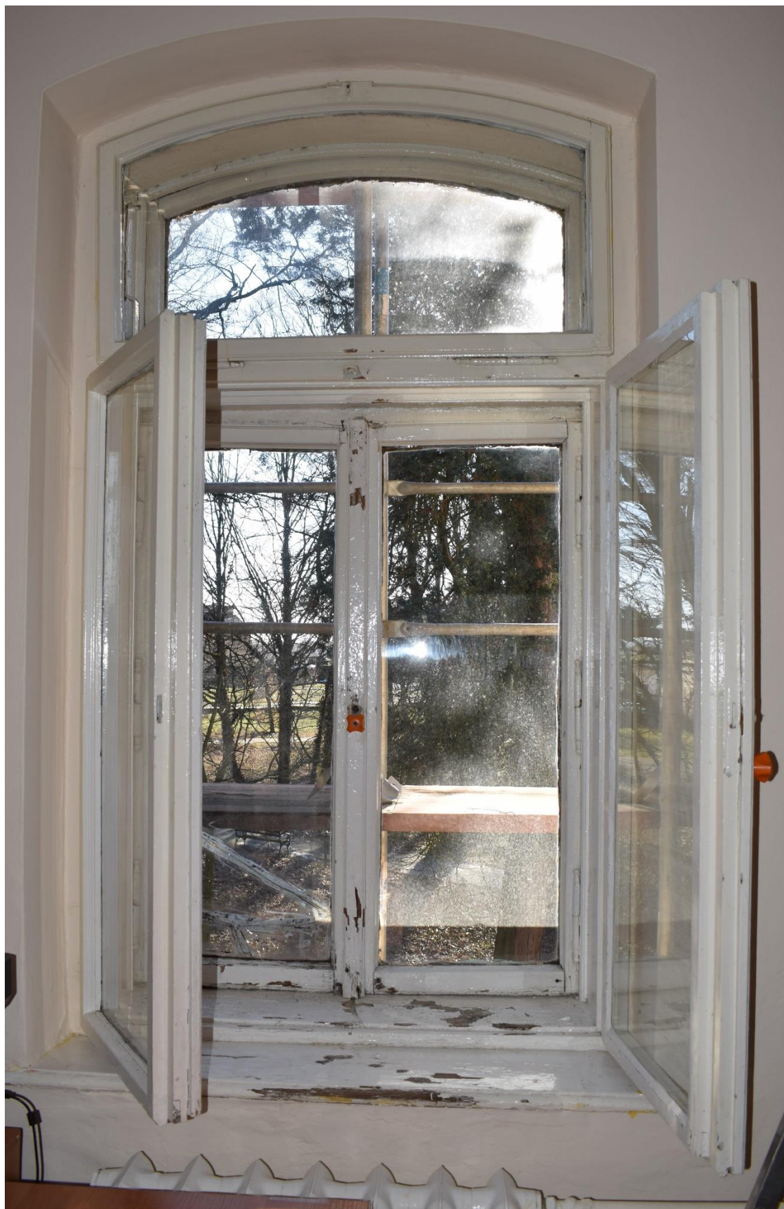
Rożwienica, budynek dworski, okno Typ IV, widok od wnętrza
