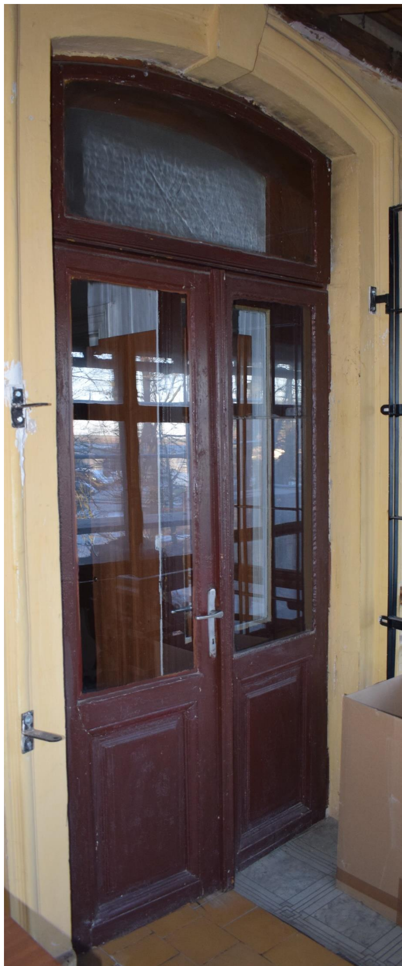
Rożwienica, budynek dworski, Typ XI, widok od zewnątrz
