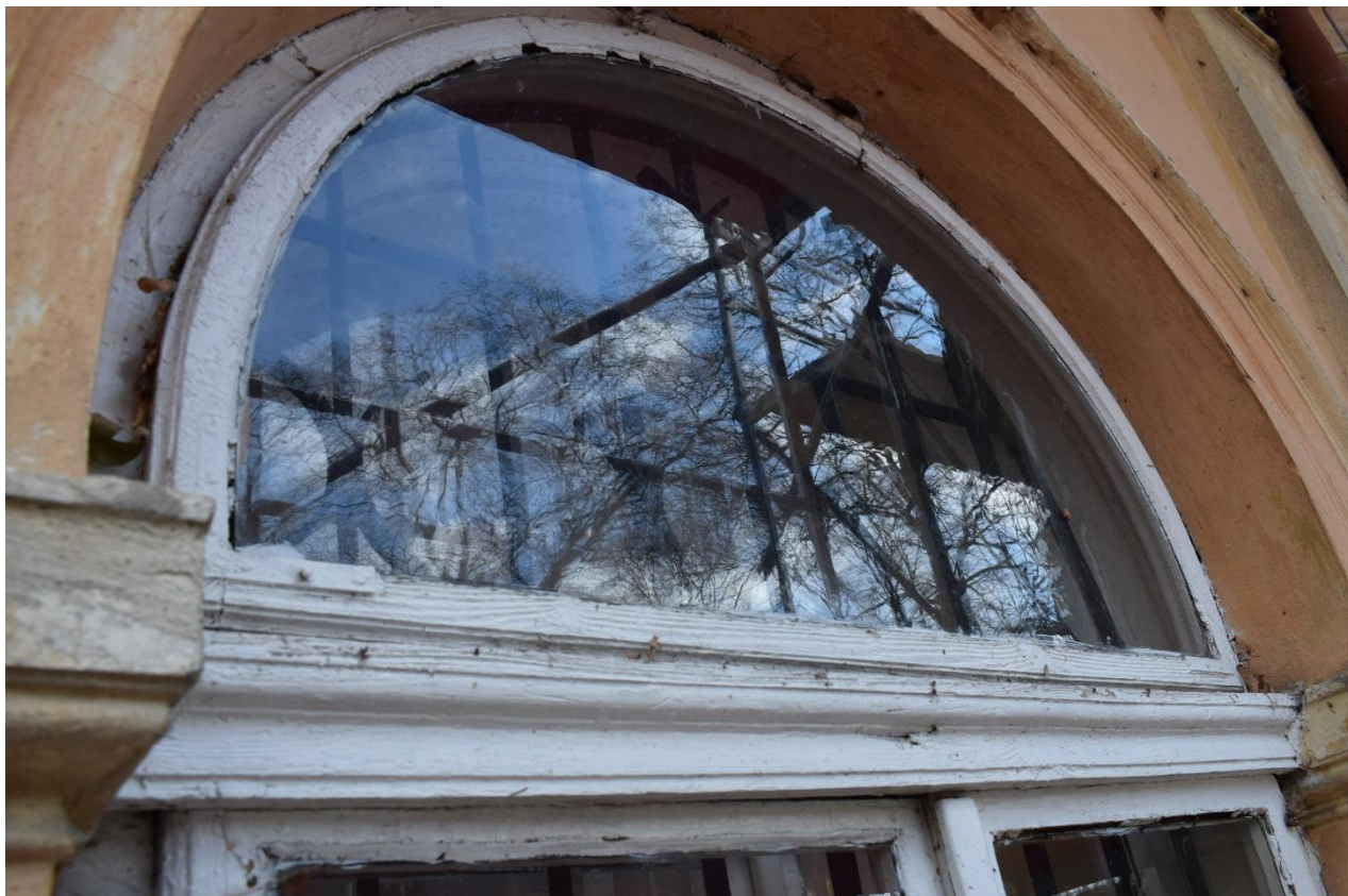
Rożwienica, budynek dworski, okno Typ III, widok od zewnątrz
