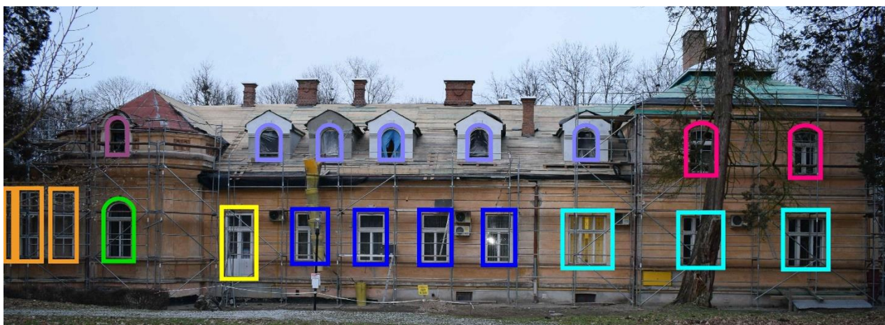
Budynek dworu w Rożwienicy, widok elewacji południowej z zaznaczonymi typami stolarki okiennej do wymiany.
