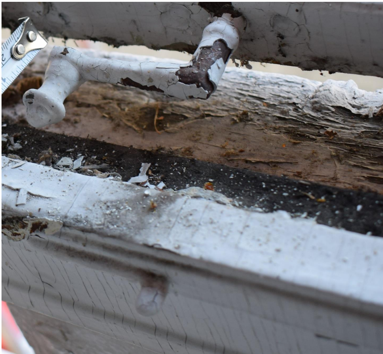
Rożwienica, budynek dworski, okno Typ I, elementy metalowe
