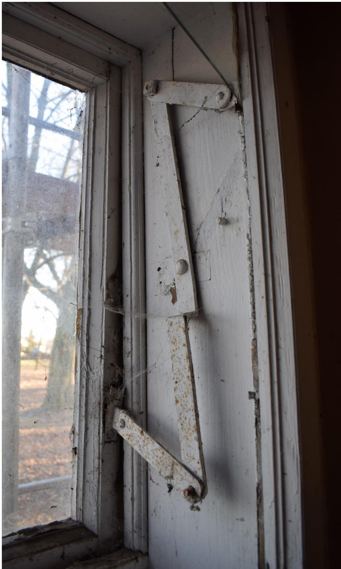
Rożwienica, budynek dworski, okno Typ V, widok od wnętrza, rozwórka okienna
