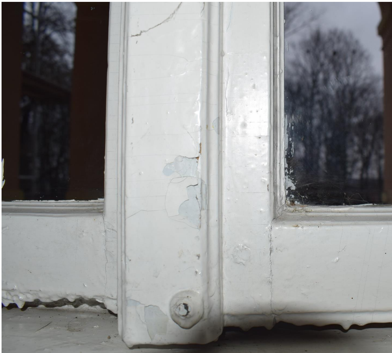
Rożwienica, budynek dworski, okno Typ II, widok od wnętrza
