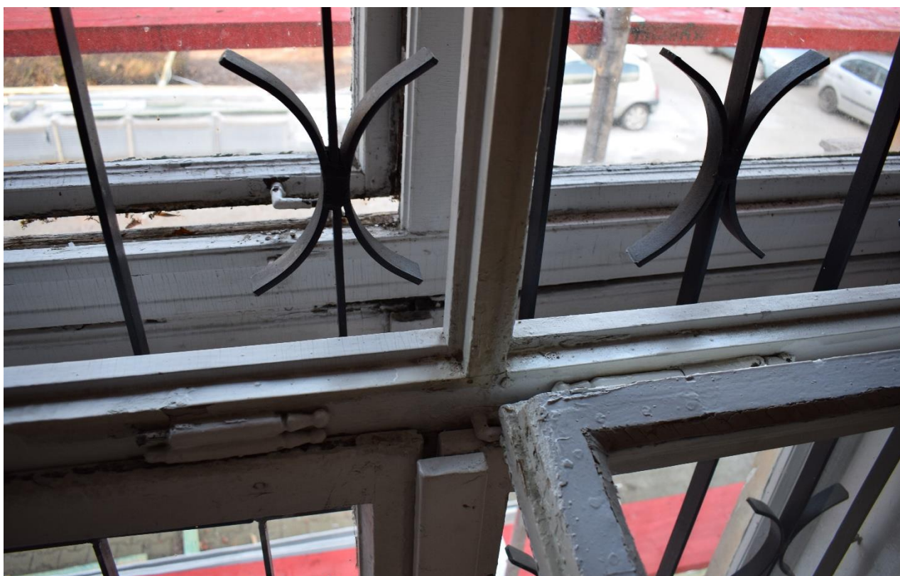
Rożwienica, budynek dworski, okno Typ I, widok od wnętrza
