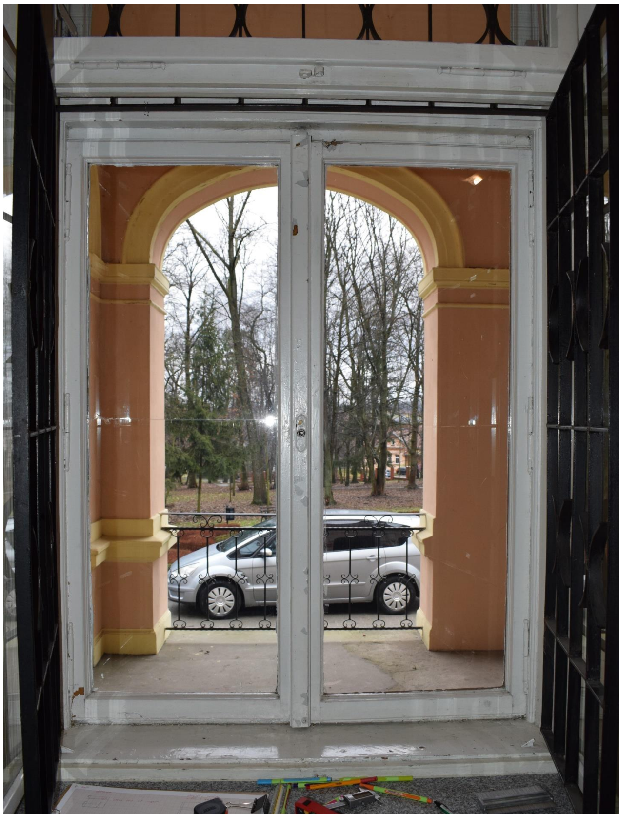
Rożwienica, budynek dworski, okno Typ II, widok od wnętrza
