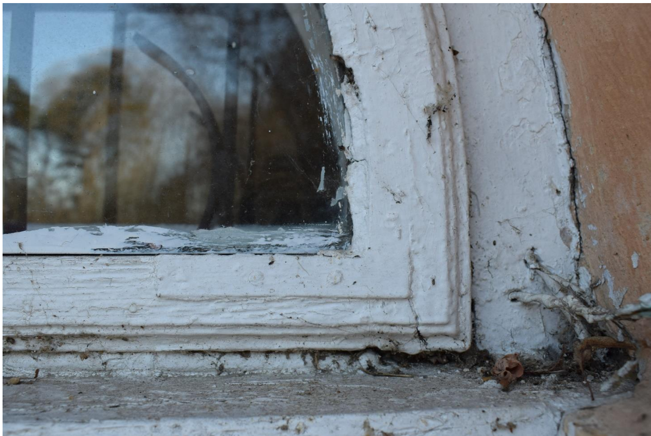
Rożwienica, budynek dworski, okno Typ I, fragment ramy
