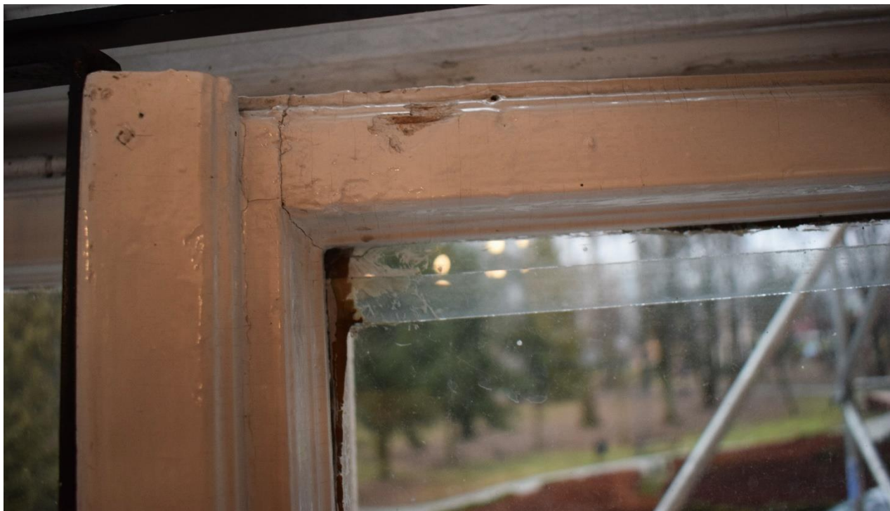
Rożwienica, budynek dworski, okno Typ I, fragment ramy
