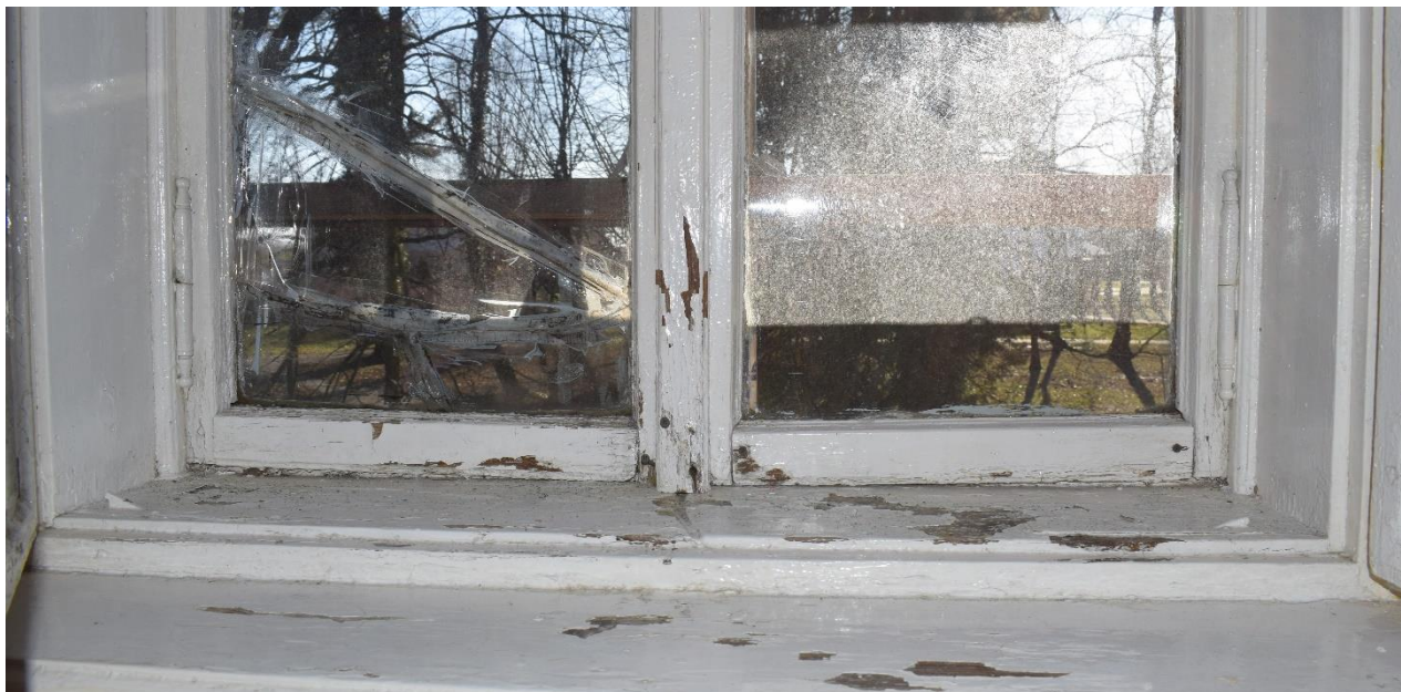
Rożwienica, budynek dworski, okno Typ IV, widok od wnętrza
