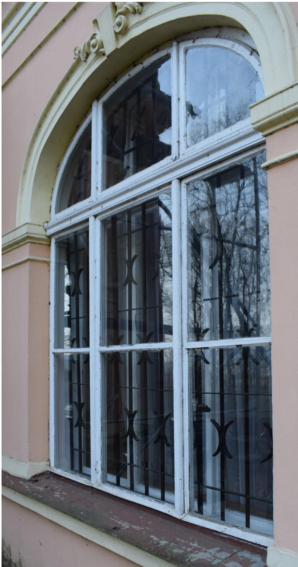
Rożwienica, budynek dworski, okno Typ I, widok od zewnątrz
