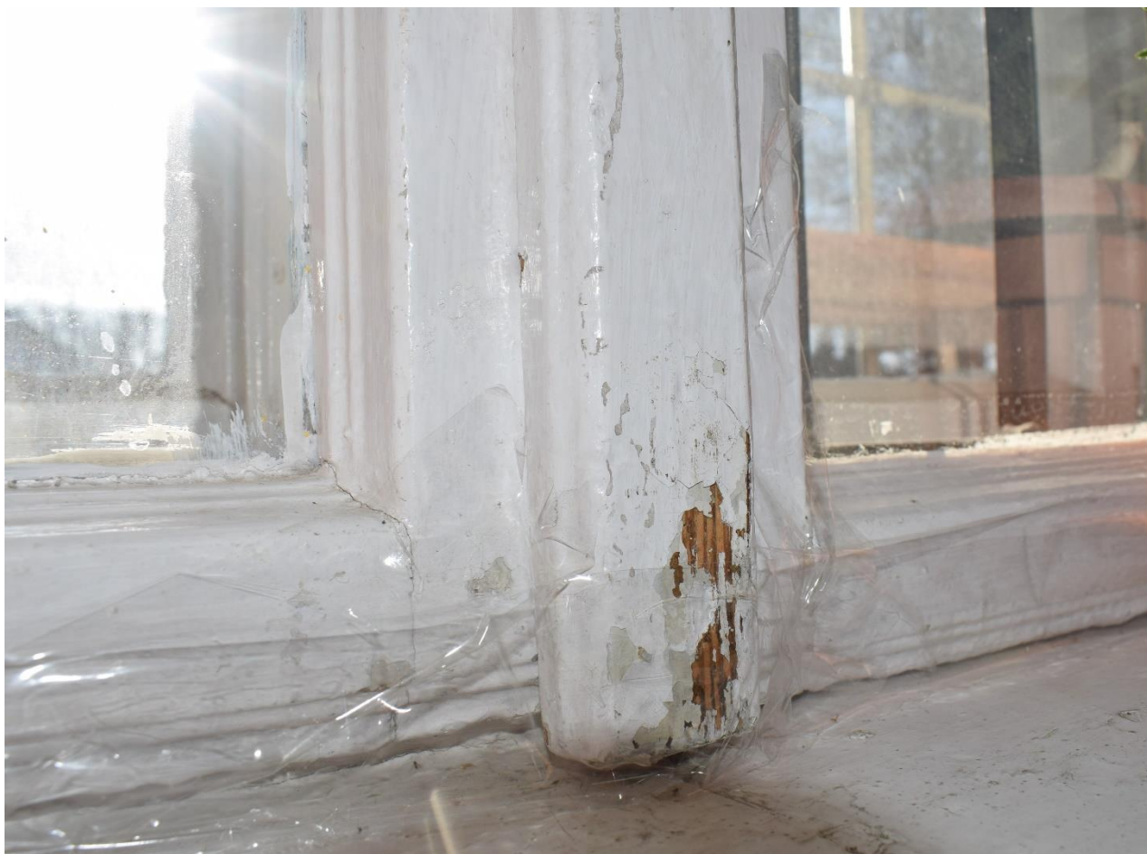
Rożwienica, budynek dworski, okno Typ II, widok od wnętrza
