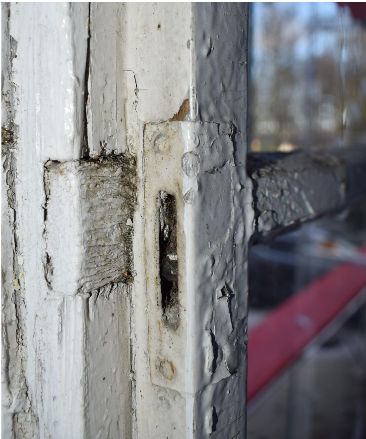
Rożwienica, budynek dworski, okno Typ I, elementy metalowe
