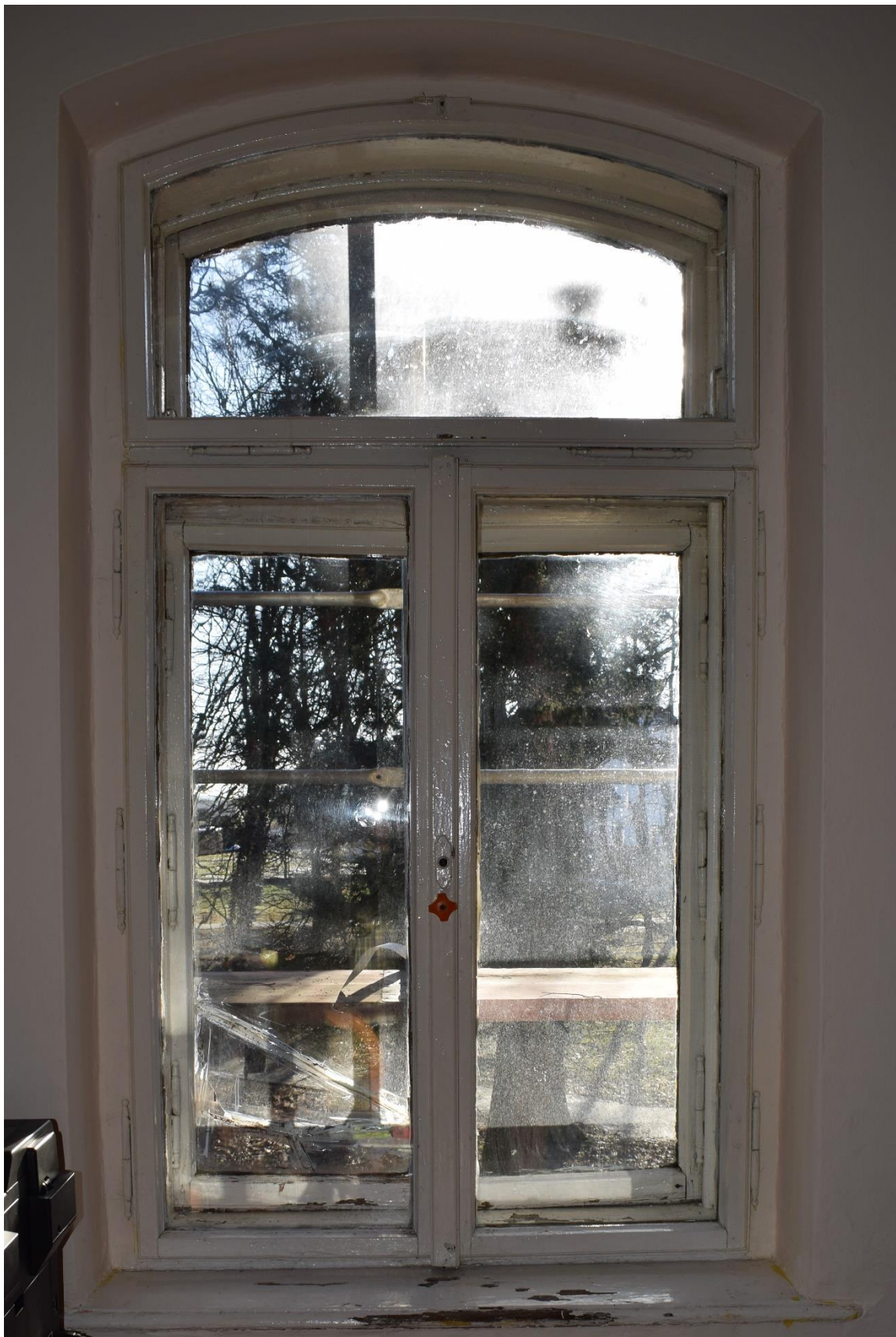
Rożwienica, budynek dworski, okno Typ IV, widok od wnętrza
