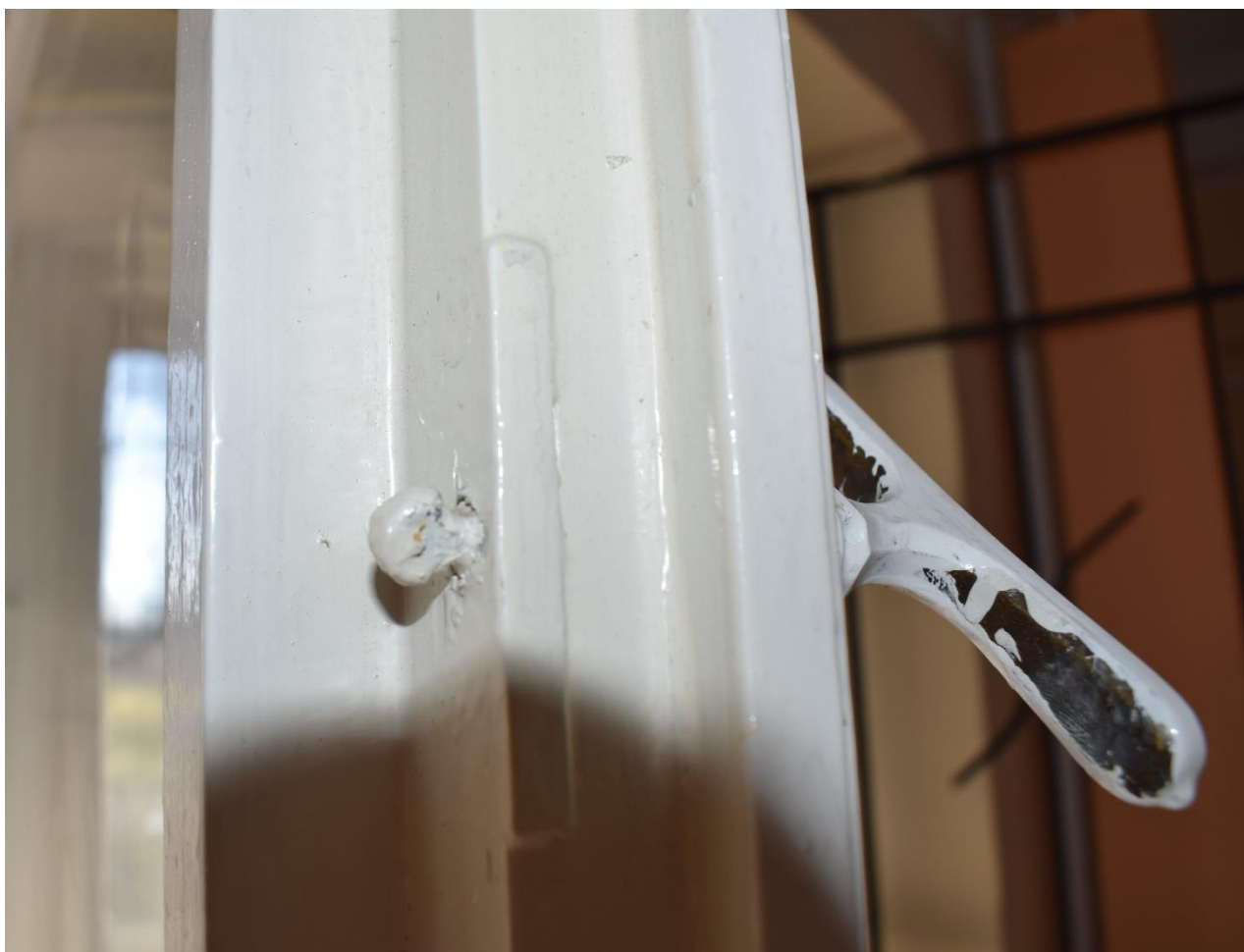
Rożwienica, budynek dworski, okno Typ VII, widok od wnętrza, elementy metalowe
