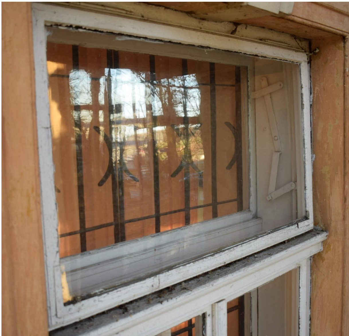
Rożwienica, budynek dworski, okno Typ II, widok od zewnątrz
