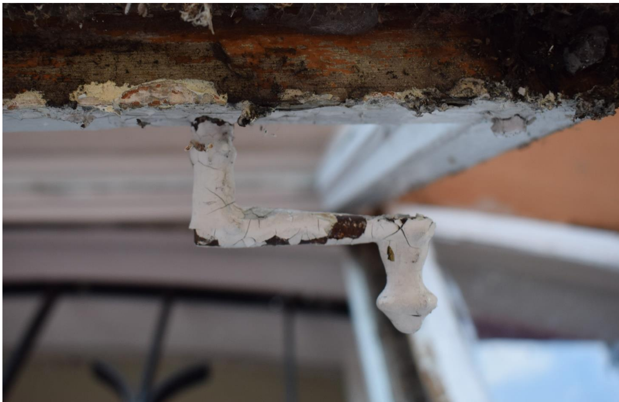
Rożwienica, budynek dworski, okno Typ I, elementy metalowe
