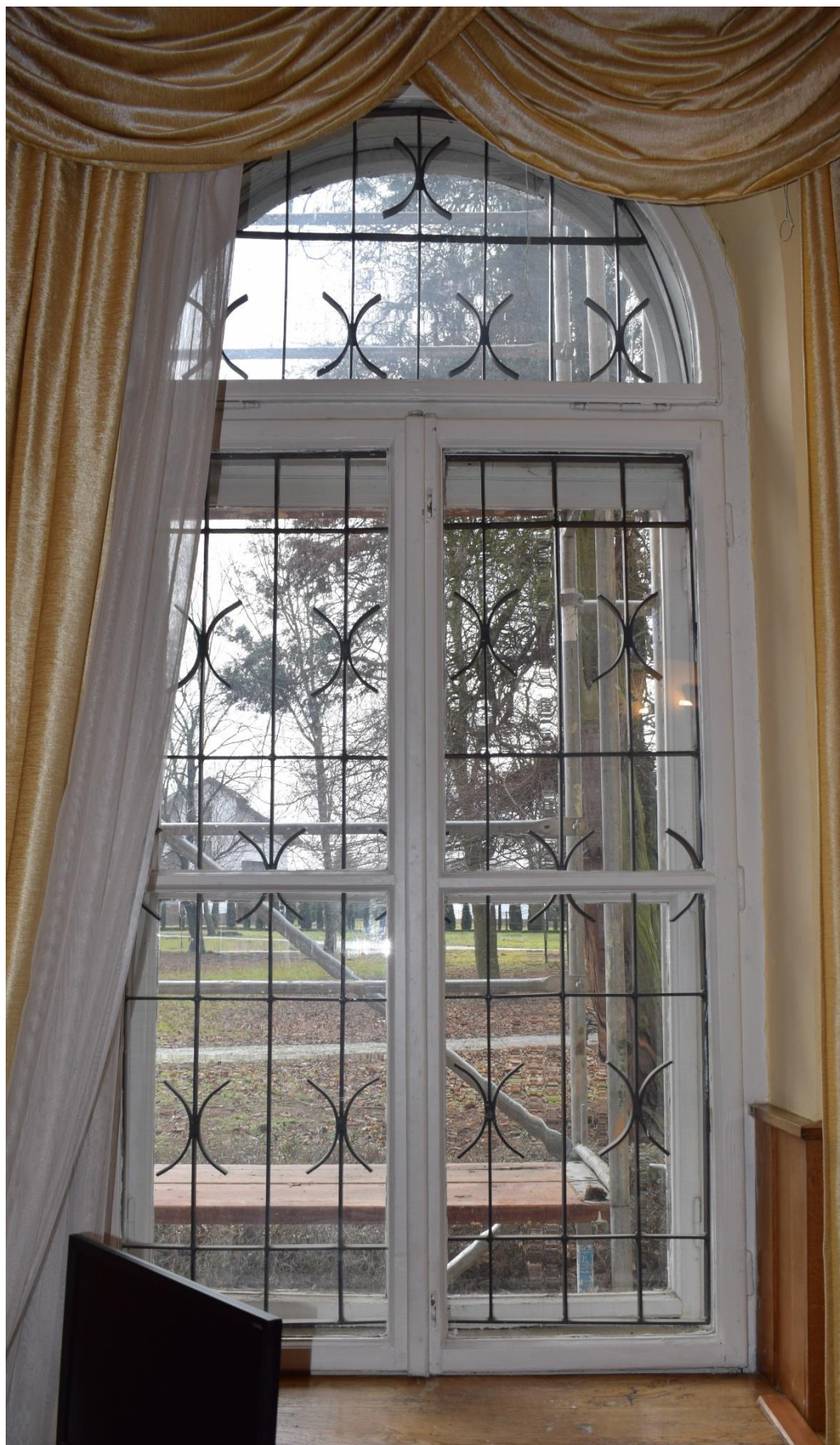
Rożwienica, budynek dworski, okno Typ III, widok od wnętrza
