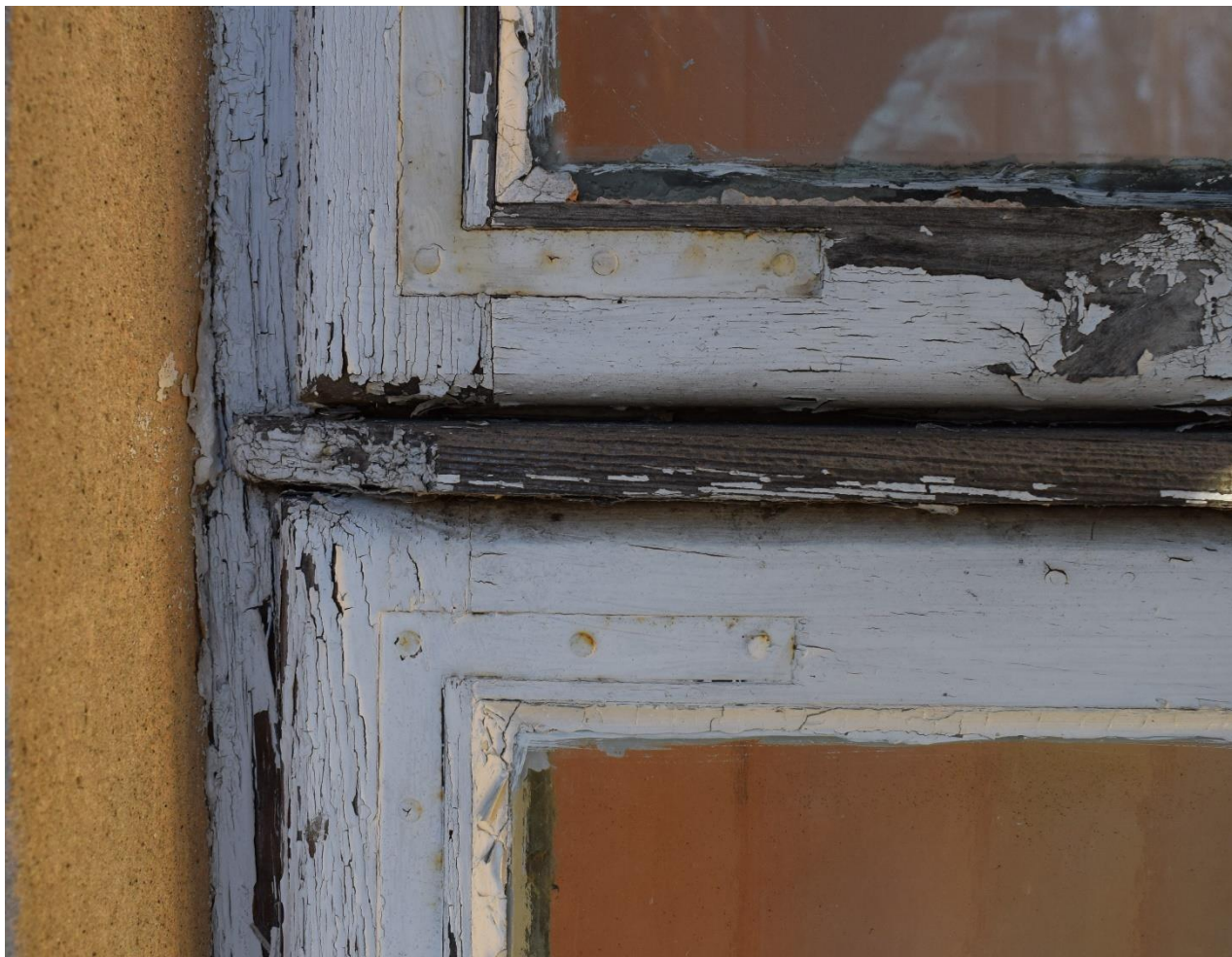
Rożwienica, budynek dworski, okno Typ VI, widok od zewnątrz
