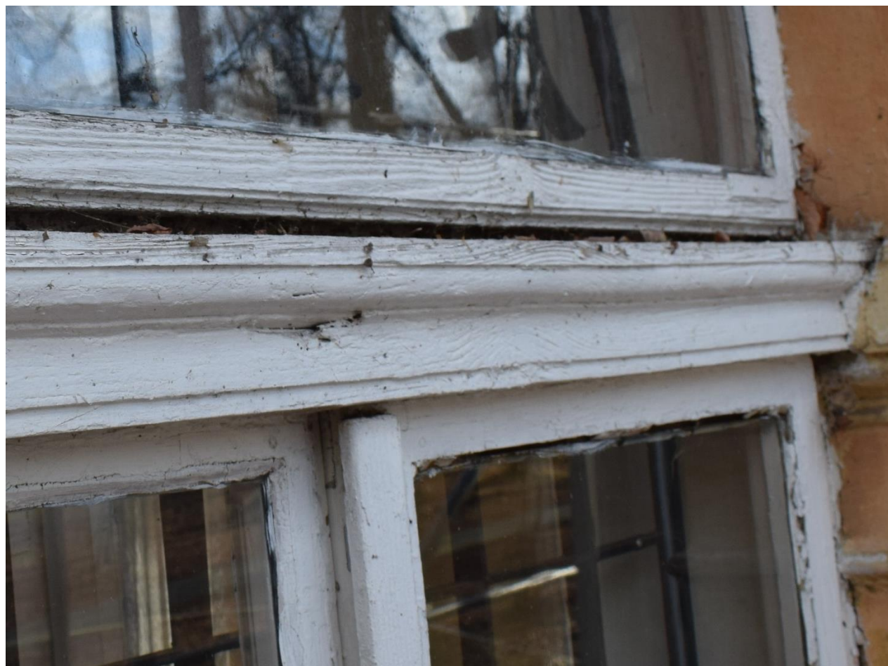
Rożwienica, budynek dworski, okno Typ III, widok od zewnątrz
