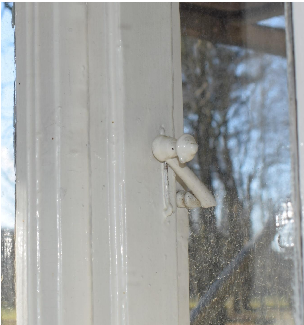
Rożwienica, budynek dworski, okno Typ VII, widok od wnętrza, elementy metalowe
