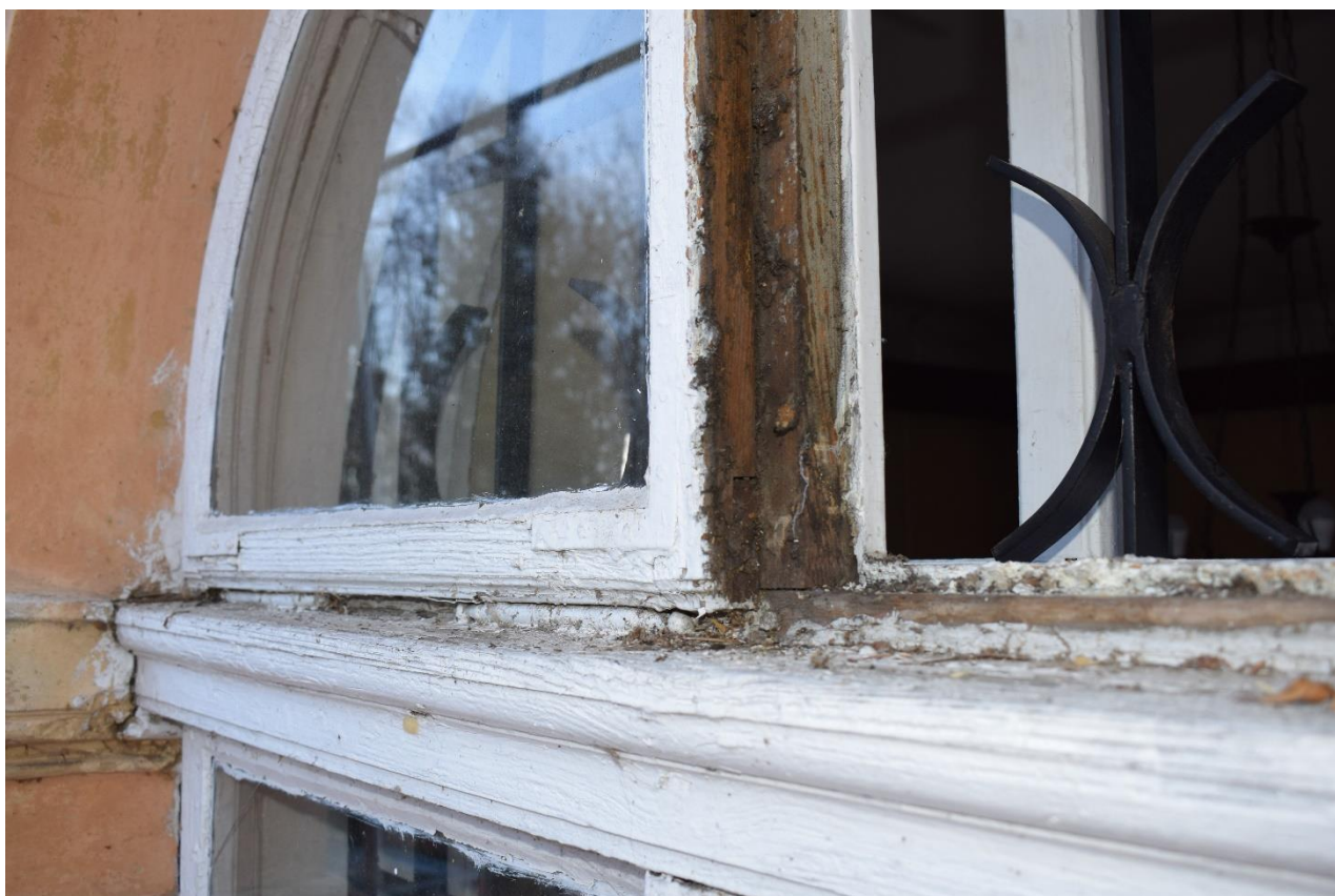
Rożwienica, budynek dworski, okno Typ I, widok od zewnątrz
