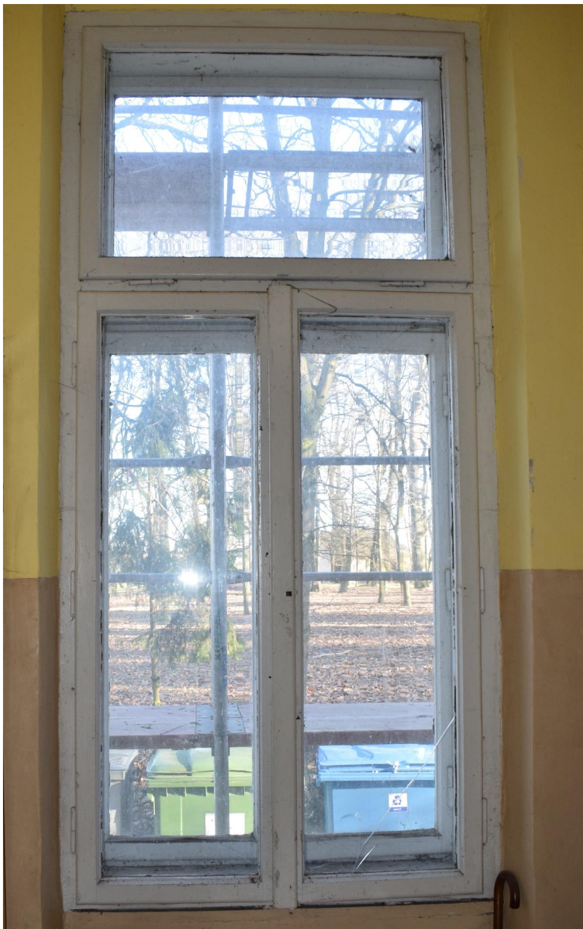
Rożwienica, budynek dworski, okno Typ V, widok od wnętrza
