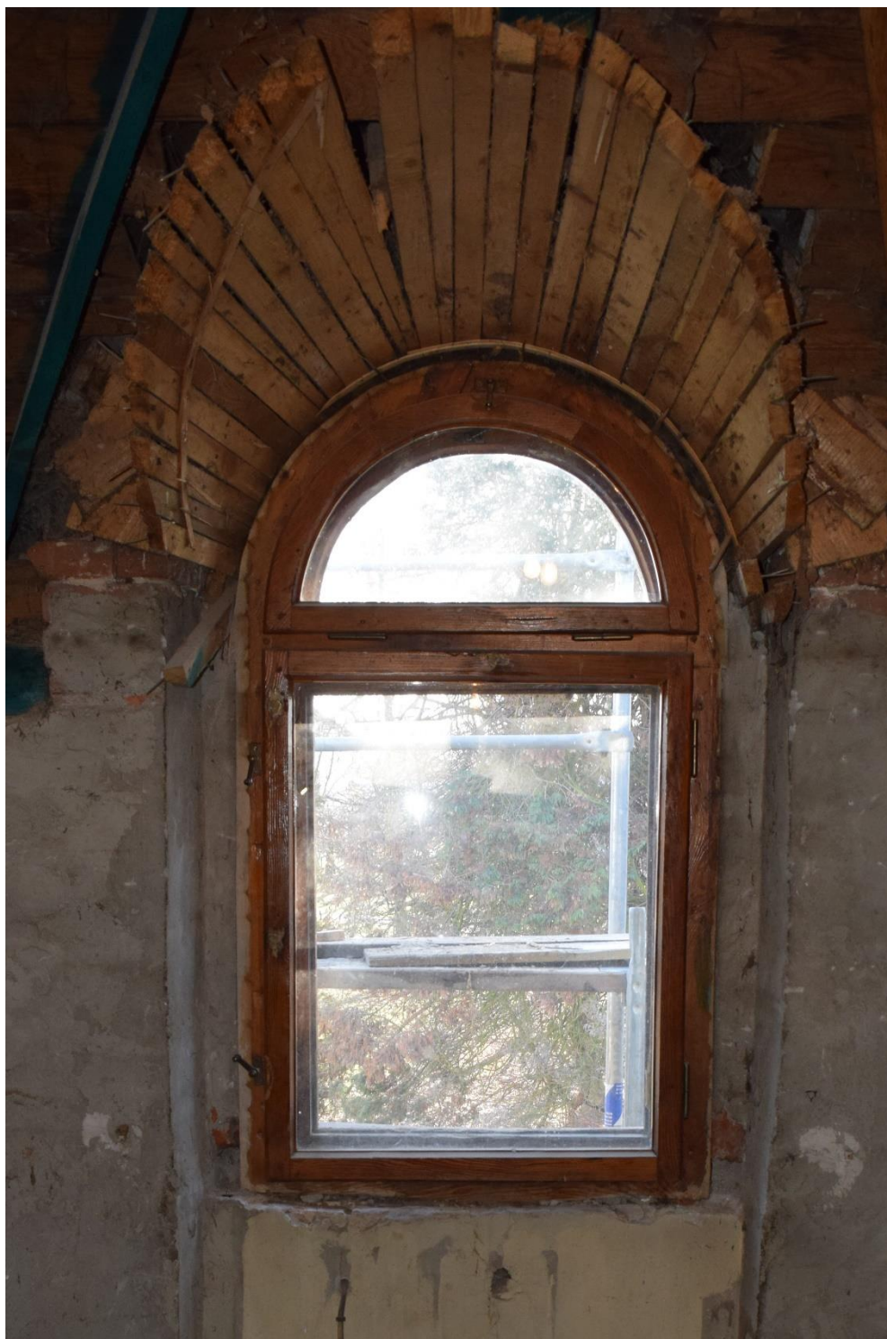
Rożwienica, budynek dworski, okno Typ VIII, widok od wnętrza
