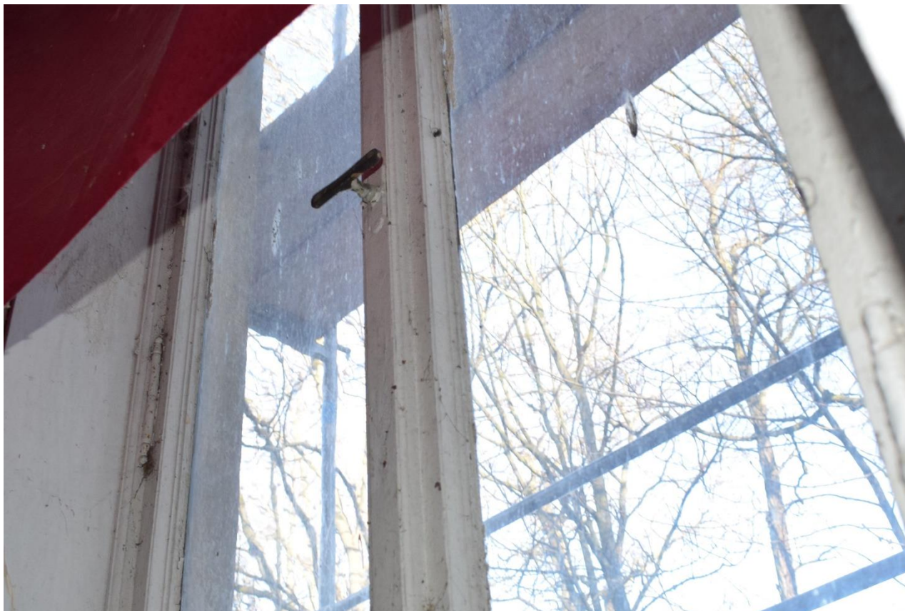
Rożwienica, budynek dworski, okno Typ V, widok od wnętrza
