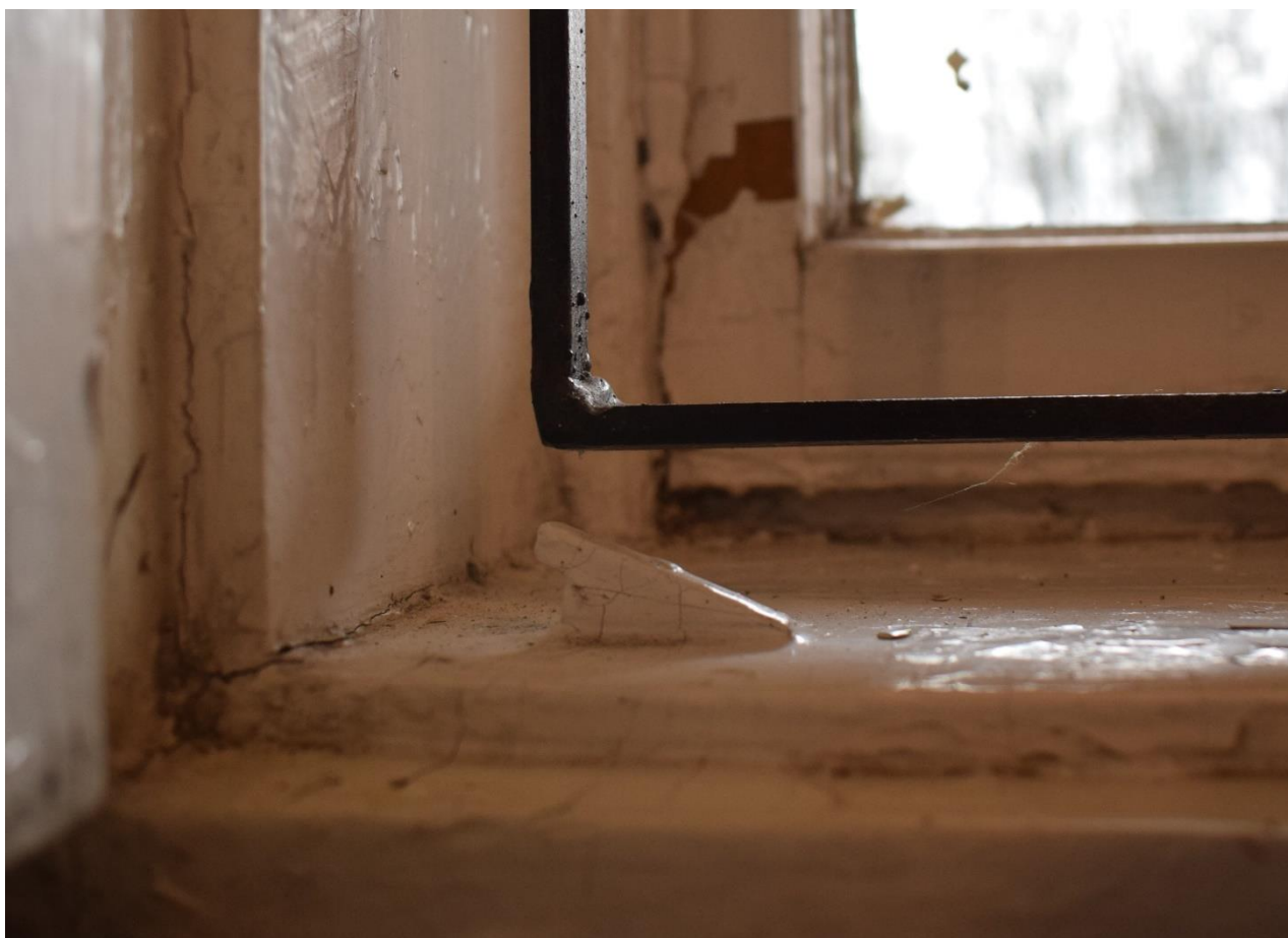
Rożwienica, budynek dworski, okno Typ II, widok od wnętrza, ogranicznik okienny
