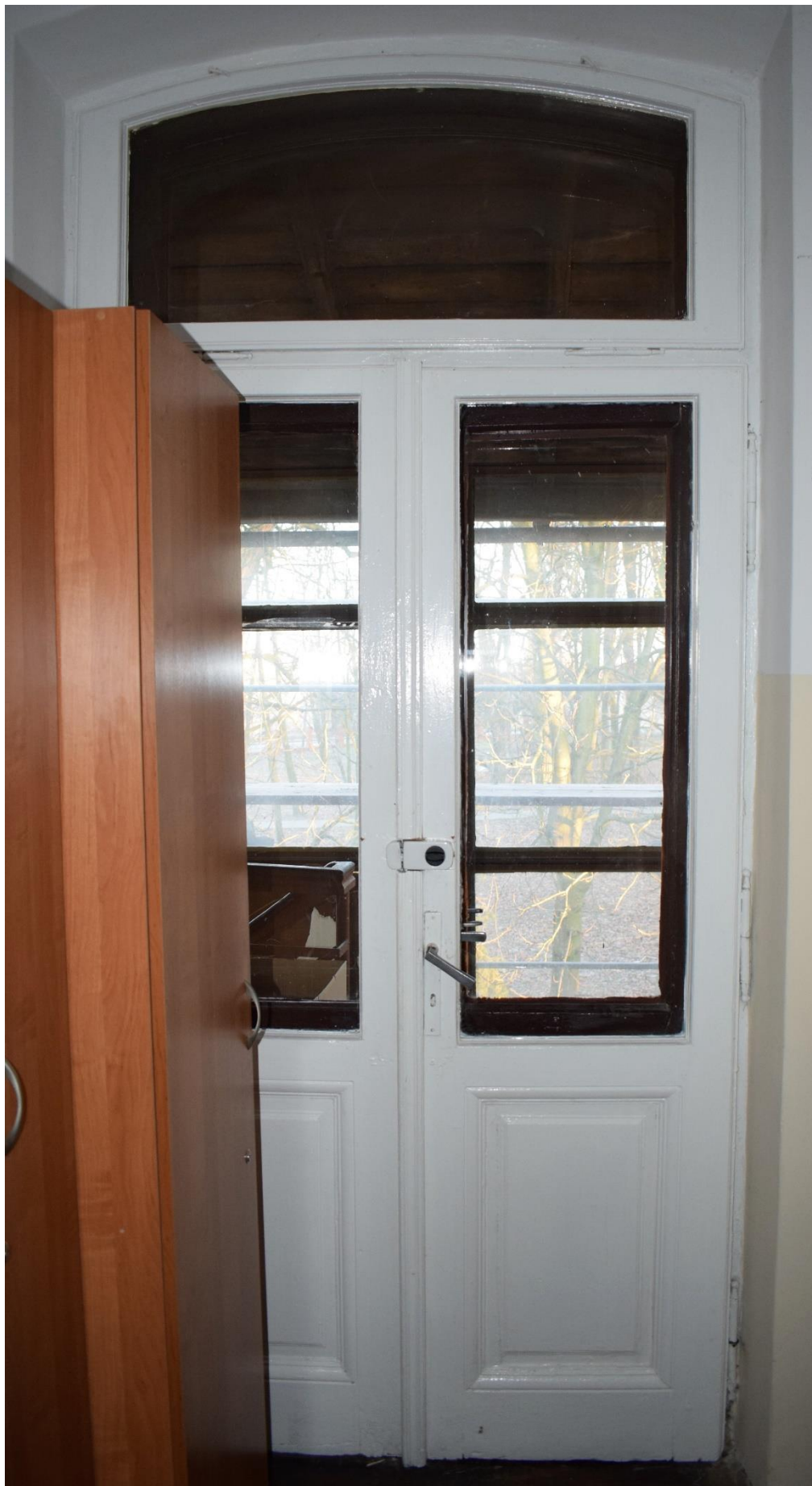
Rożwienica, budynek dworski, Typ XI, widok od wnętrza
