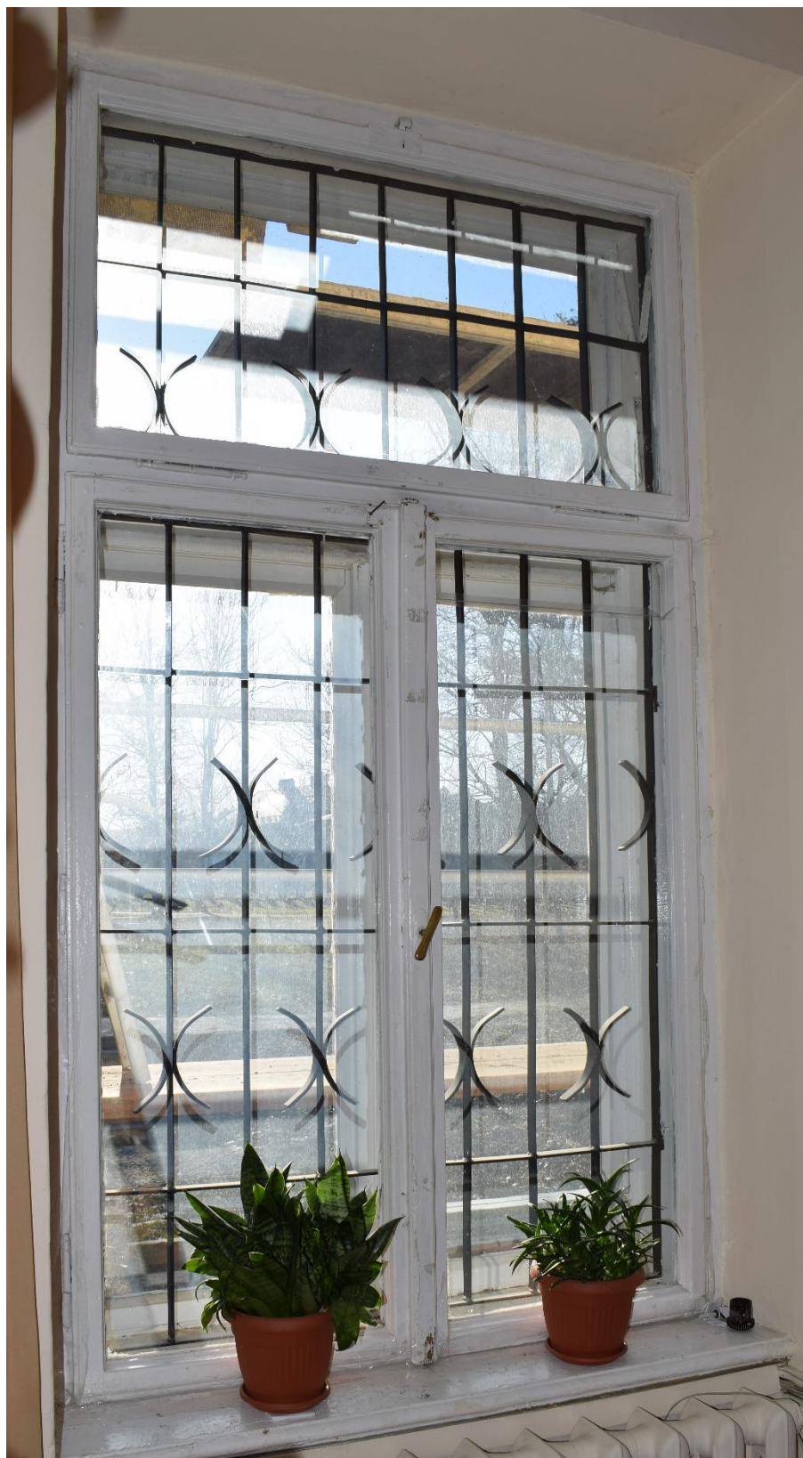
Rożwienica, budynek dworski, okno Typ II, widok od wnętrza
