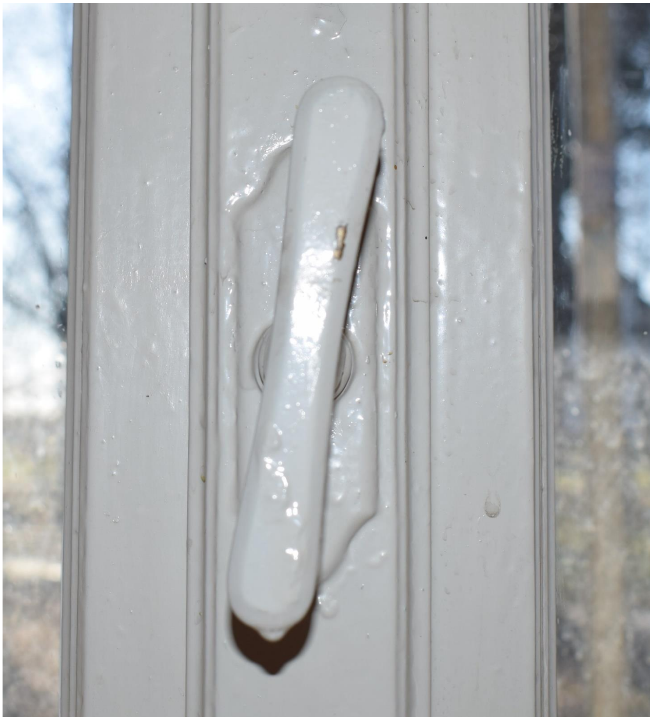
Rożwienica, budynek dworski, okno Typ VII, widok od wnętrza, elementy metalowe
