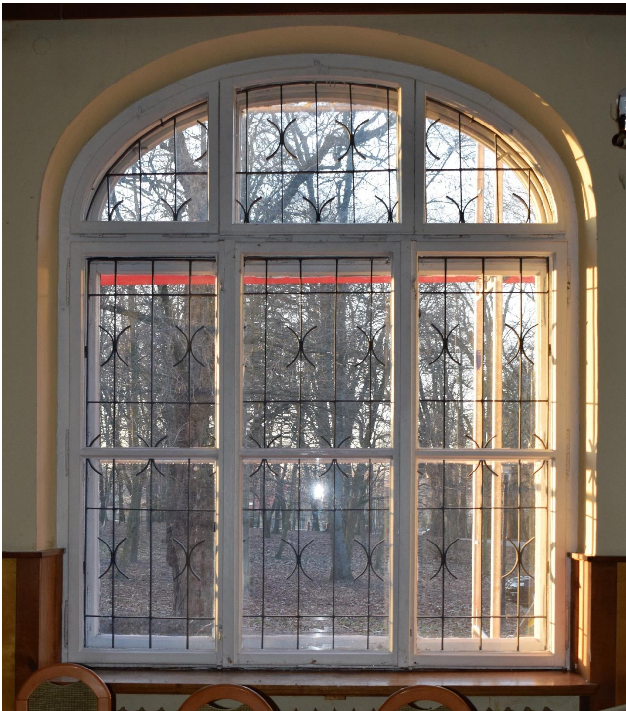
Rożwienica, budynek dworski, okno Typ I, widok od wnętrza
