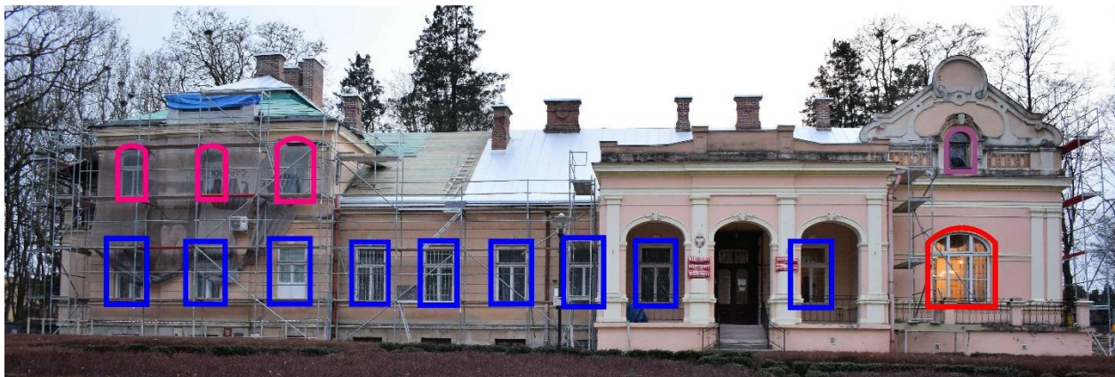
Budynek dworu w Rożwienicy, widok fasady z zaznaczonymi typami stolarki okiennej do wymiany.
