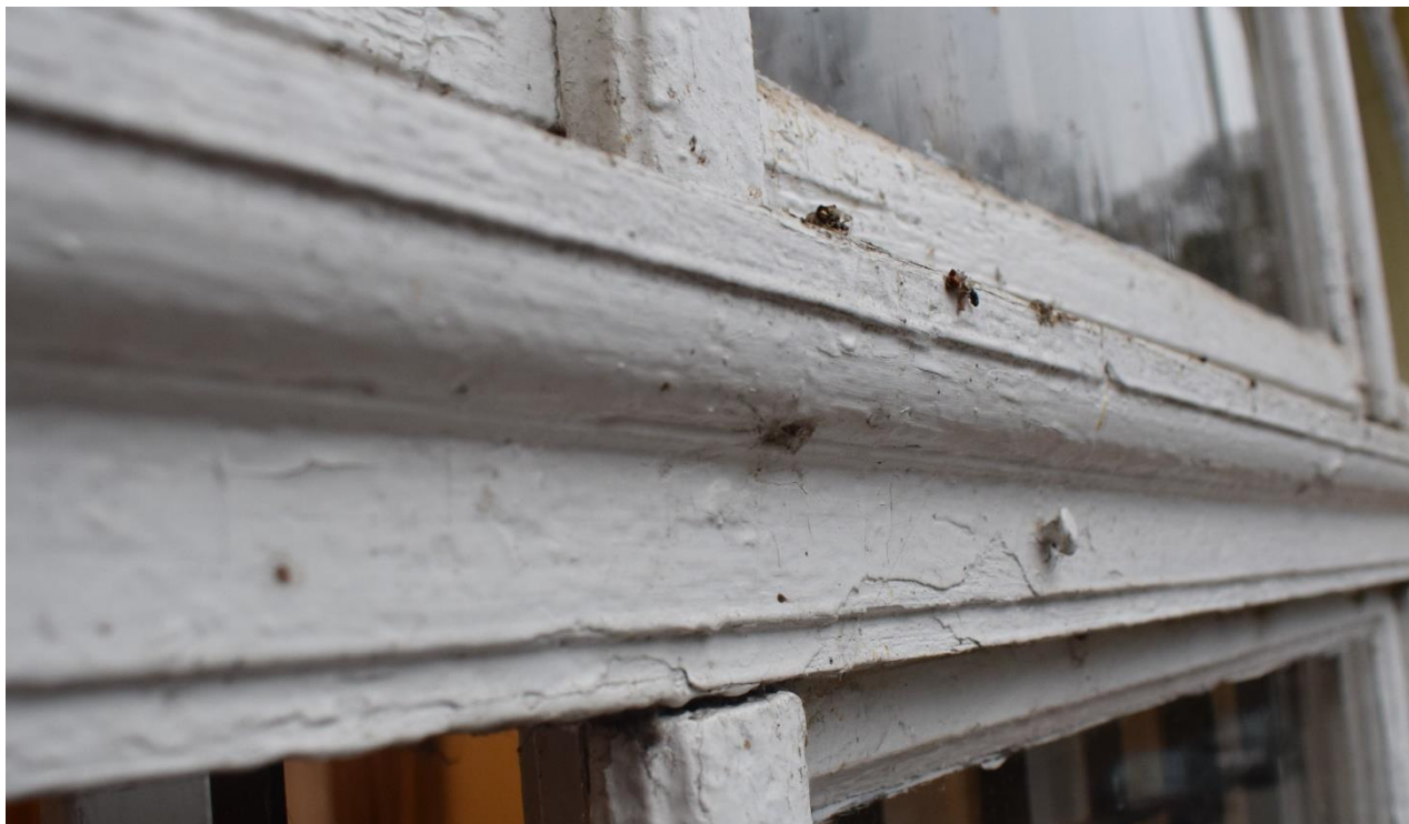
Rożwienica, budynek dworski, okno Typ I, widok od zewnątrz
