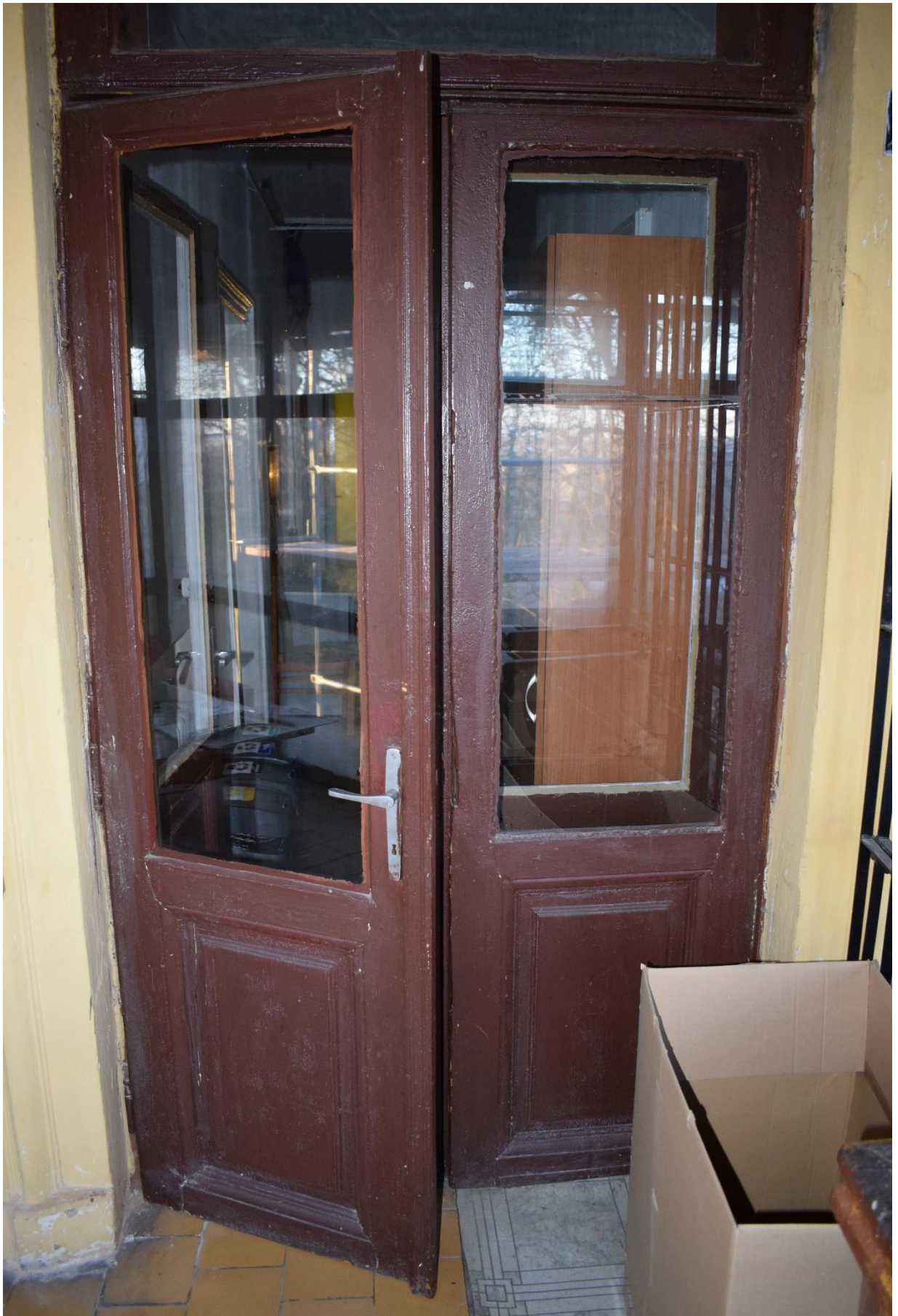
Rożwienica, budynek dworski, Typ XI, widok od zewnątrz
