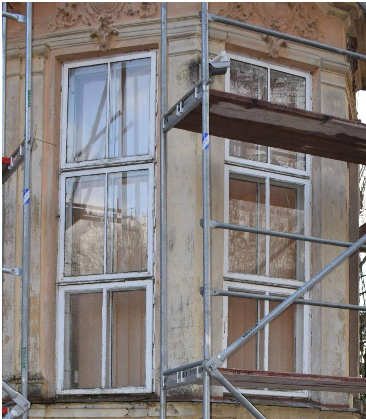
Rożwienica, budynek dworski, okno Typ VI, widok od zewnątrz
